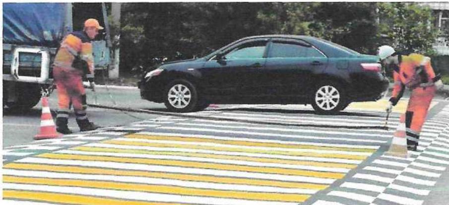
Рисунок 2.15.4 - Пример использования приподнятого пешеходного перехода
